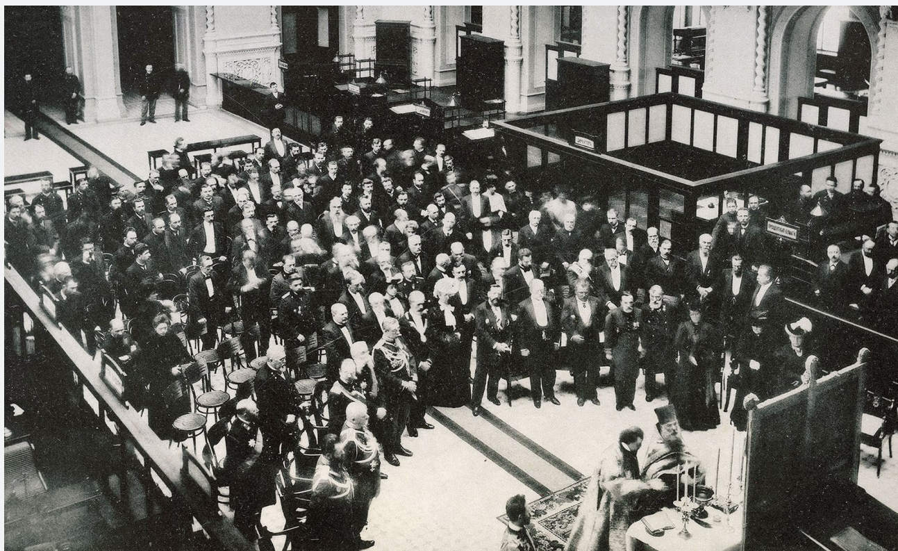
Освячення будівлі 22 лютого 1906 року
